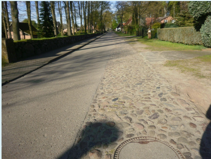
Unter den Eichen 5,0 m breit ab Einmündung Heidberg mit historischen Pflaster 1,5 m + 3,0 m Beton
